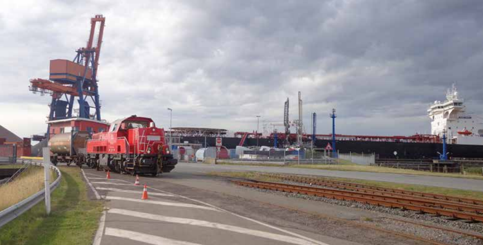
Der Direktumschlag vom Schiff auf die Schiene stärkt den Elbehafen als Logistikstandort und verringert den LKW-Verkehr.
