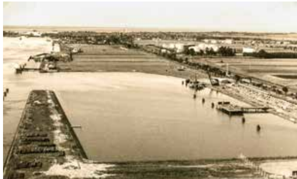
Fertigstellung des ersten Bauabschnitts, 1959.
