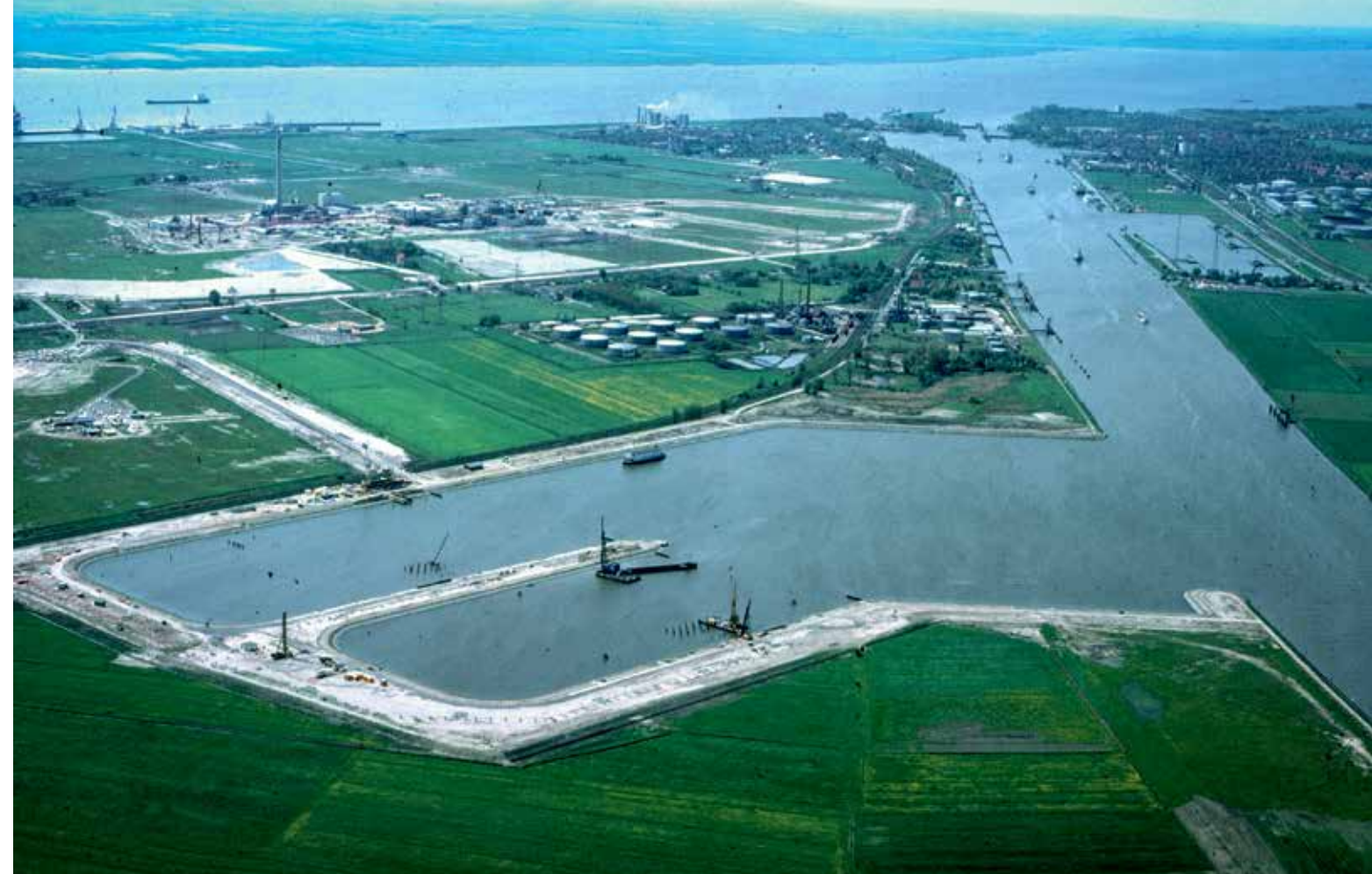
Blick auf den im Bau befindlichen Hafen Ostermoor und die Kanalregion.
