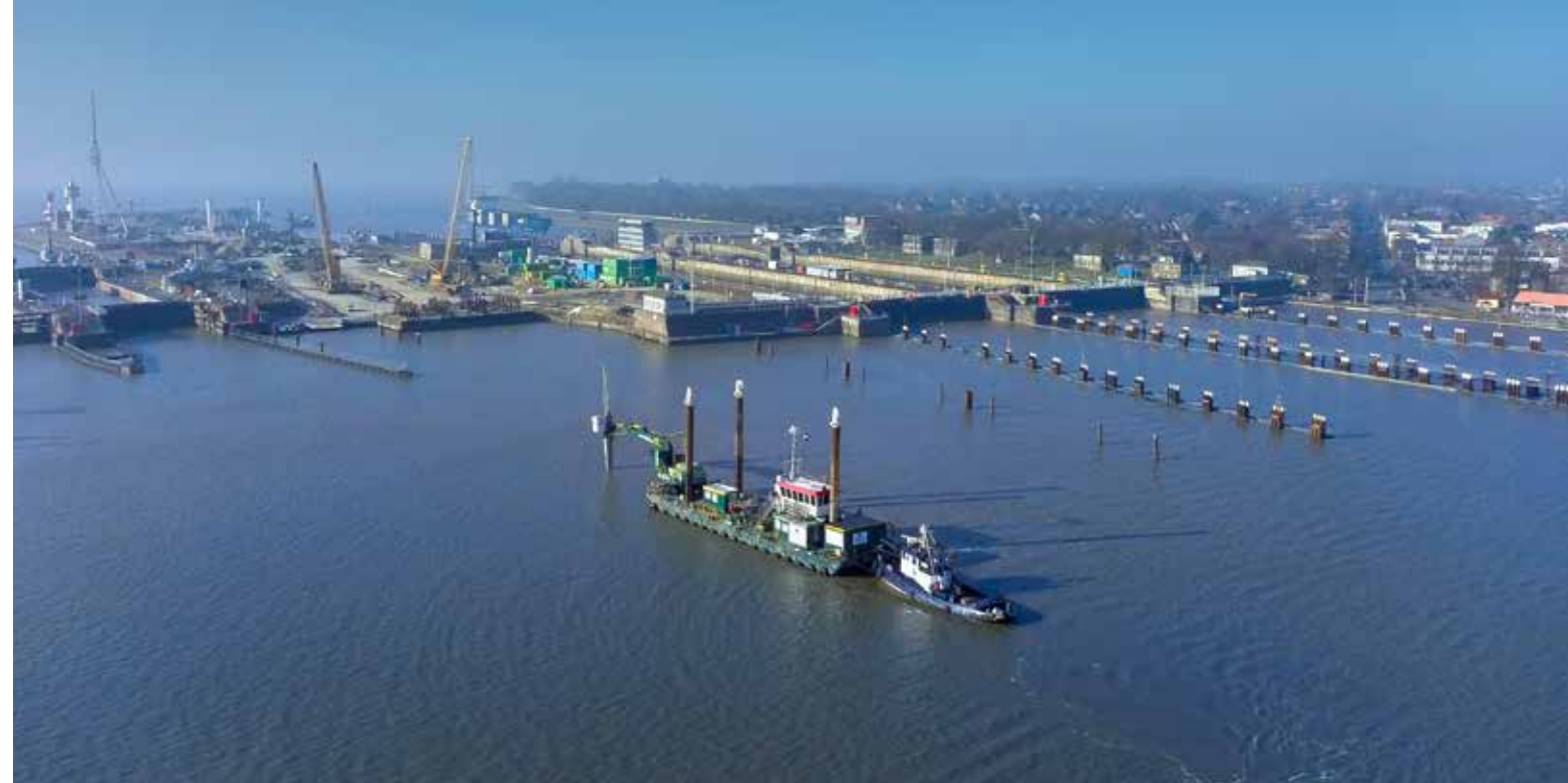
Schlepper VORWÄRTS vor den Brunsbütteler Schleusen.
