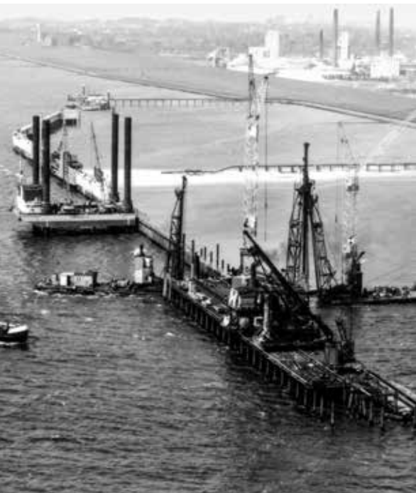
Mit ihren Schiffen und Schwimmkränen war die Firma Schramm bereits am Bau des Elbehafens beteiligt.
