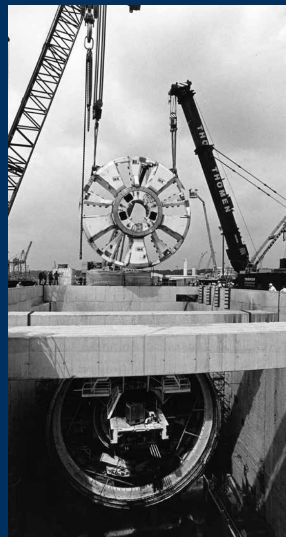
Montage des Tunnelbohrers T.R.U.D.E. zum Bau der vierten Elbtunnelröhre.
