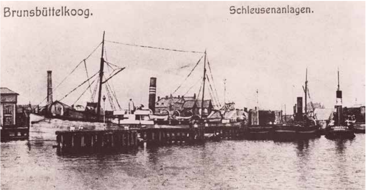
Schleusenanlagen in Brunsbüttelkoog.
