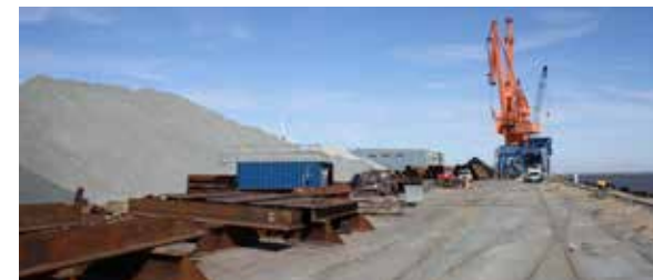
Arbeiten zur Verlegung der neuen Bahngleise direkt am Kai.
